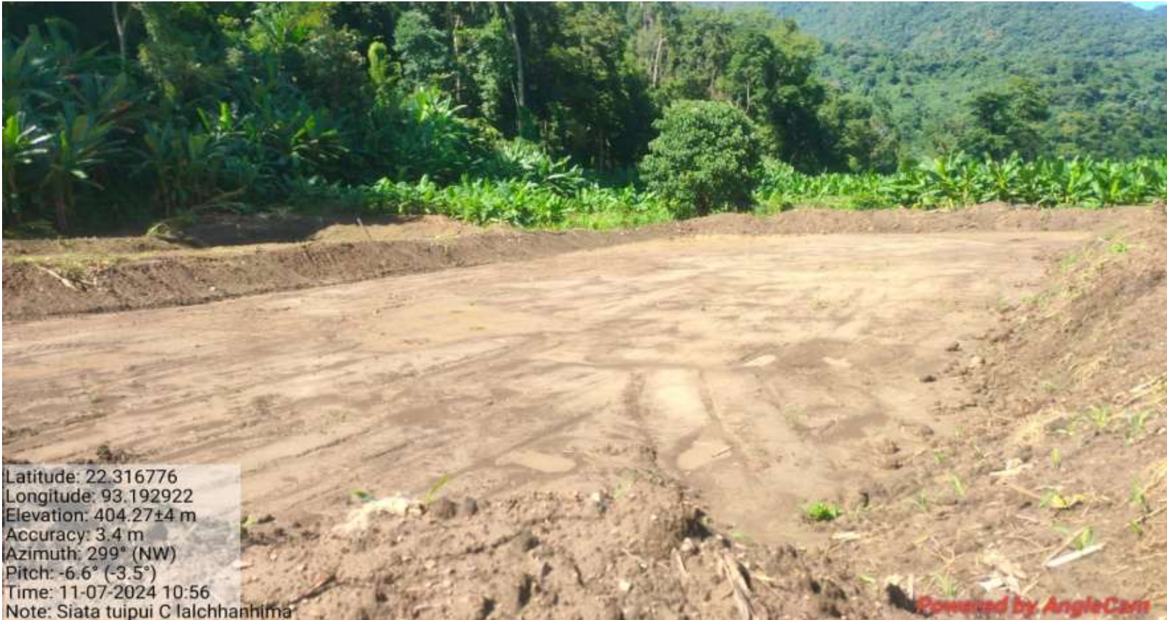
New Pond Construction K. Venisia College Vaih, Siaha
